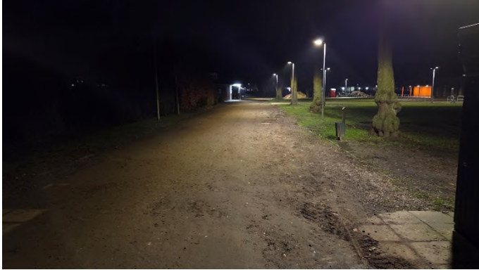
Neue Beleuchtung an der neuen Stadionhalle
